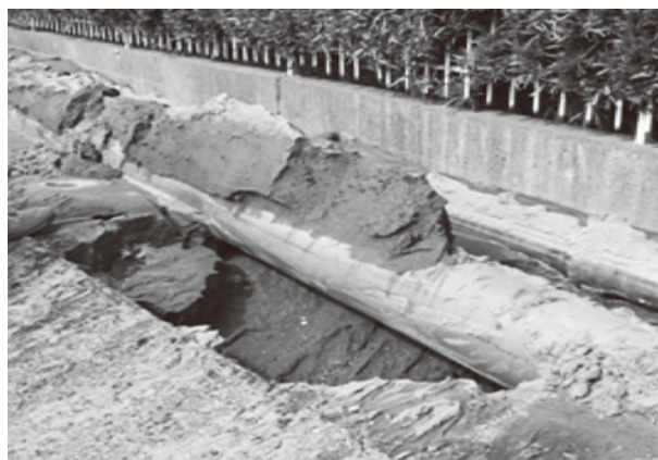
液状化現象による配管の浮き上がり(国土交通省関東地方整備局) http://www.mlit.go.jp/toshi/toshi_fr1_000011.html
